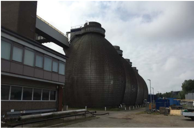
Abbildung 47: Faultürme der Kläranlage Seehausen
