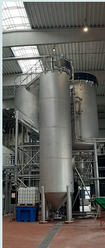
Links: Struvitfällungsreaktor des Abwasserverbands Braunschweig (Foto: SEBS); oben rechts: Struvitgranulat der SF-SoepenberGmbH (Foto: Agrarmarketing Detailreich); Mitte rechts: mit Struvitdünger versorgtes Maisfeld (Foto: Keßeler); unten rechts: Akteure im Dialog bei der Abschlussveranstaltung (Foto: ISOE).
